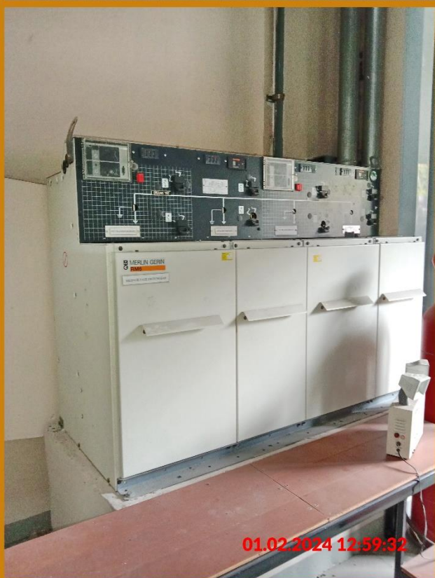
รูปที่ 43 รูปห้องหม้อแปลงไฟฟ้า (ต่อ)
